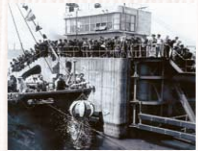
ニロック完成/日本初閘門式防潮堤(昭和30年)
